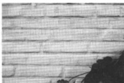
Vandskuring med brændte fuger
