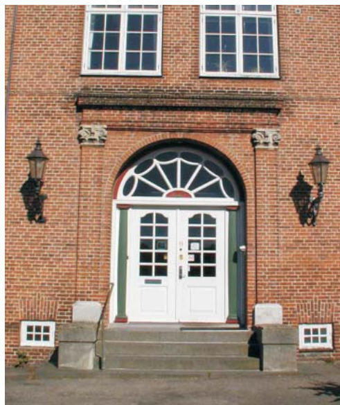
Tofløjet dør i en skole-bygning fra starten af 1900-tallet.
