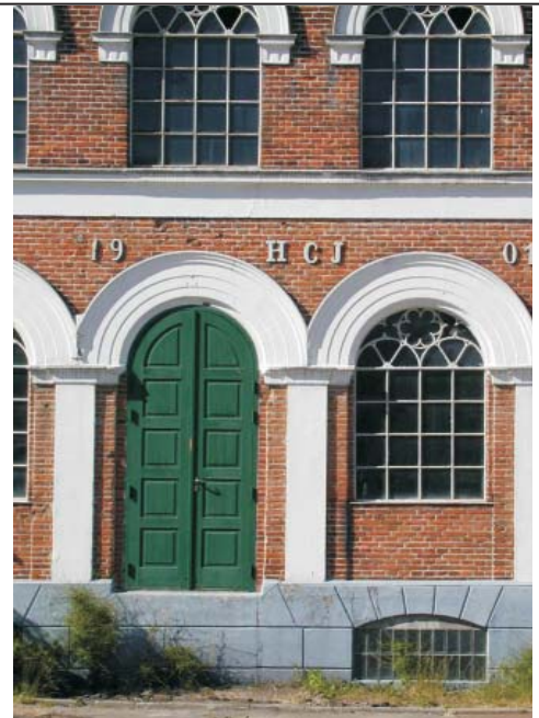
En tofløjet dør, der ligesom vinduerne er fint tilpasset den buede åbning i facaden.
