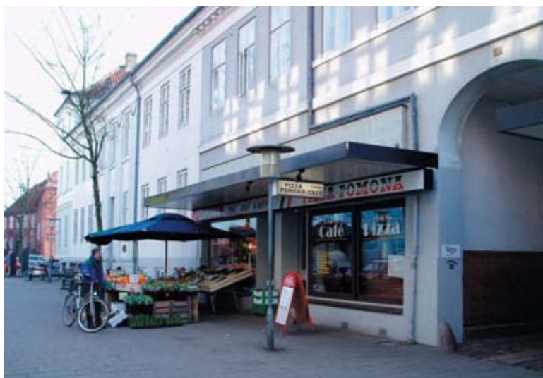
Baldakinen strækker sig langt ud i gaderummet og kommer tæt på både belysning og parasoller.
