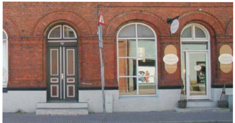
En bygning, hvor der både findes en tofløjet fyldningsdør og en moderne dør, primært af glas. Døren til højre er asymmetrisk, hvilket giver facaden et uharmonisk præg.
