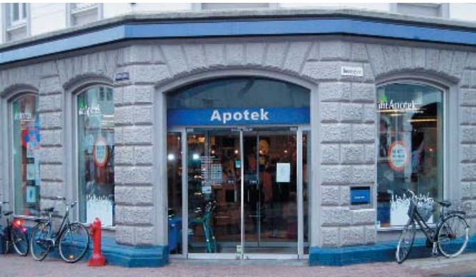
En moderne butiksdør i glas og stål, hvor forskellen på butiksvinduernes og indgangsdørens udformning opleves mindre, end den er.
